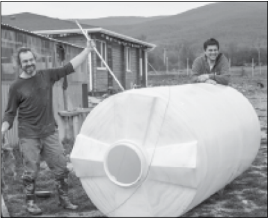
Установка водного резервуара, где летом может собираться вода
