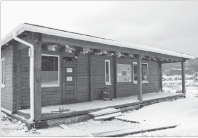
Бунгало для инструкторов в процессе строительства
