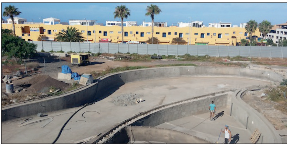
Работы по строительству бассейна Дзамлинг Гар почти окончены. Инаугурация запланирована на Новый год.
