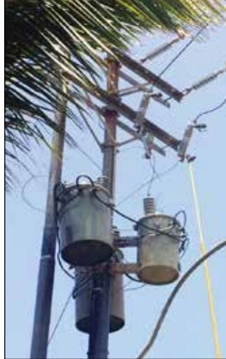
I trasformatori dopo il lavoro.
