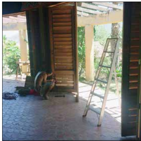
Riparazione delle porte di legno.
