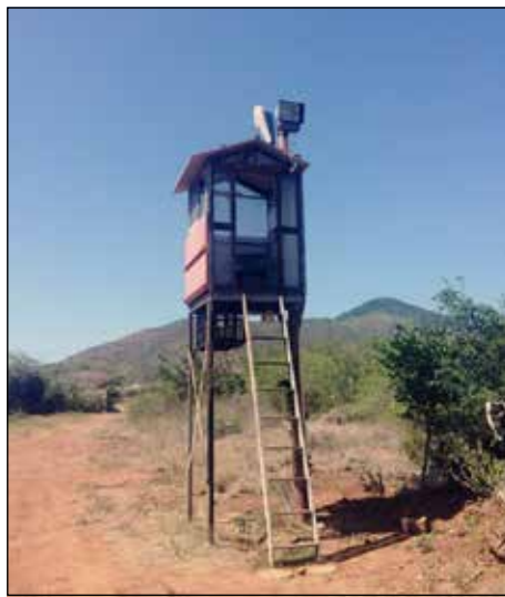
Torre di controllo occidentale con la nuova zanzariera e il nuovo sistema UPS.
